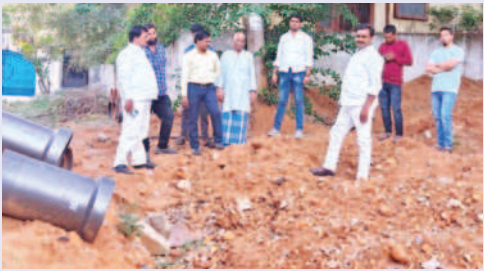
బండ్లగూడ జాగీర్ కార్పొరేషన్లోని 7వ వార్డులో భూగర్భ డ్రైనేజి పనులు పరిశీలిస్తున్న మేయర్ మహేందర్ గౌడ్
